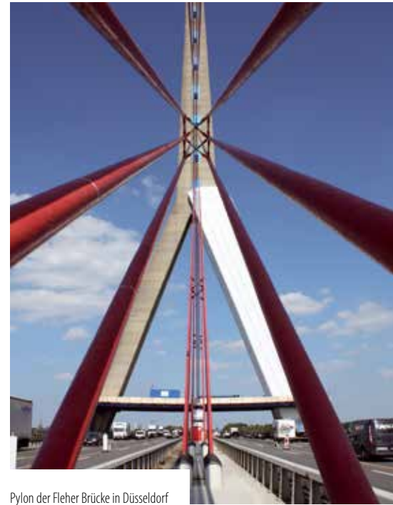
Pylon der Fleher Brücke in Düsseldorf
